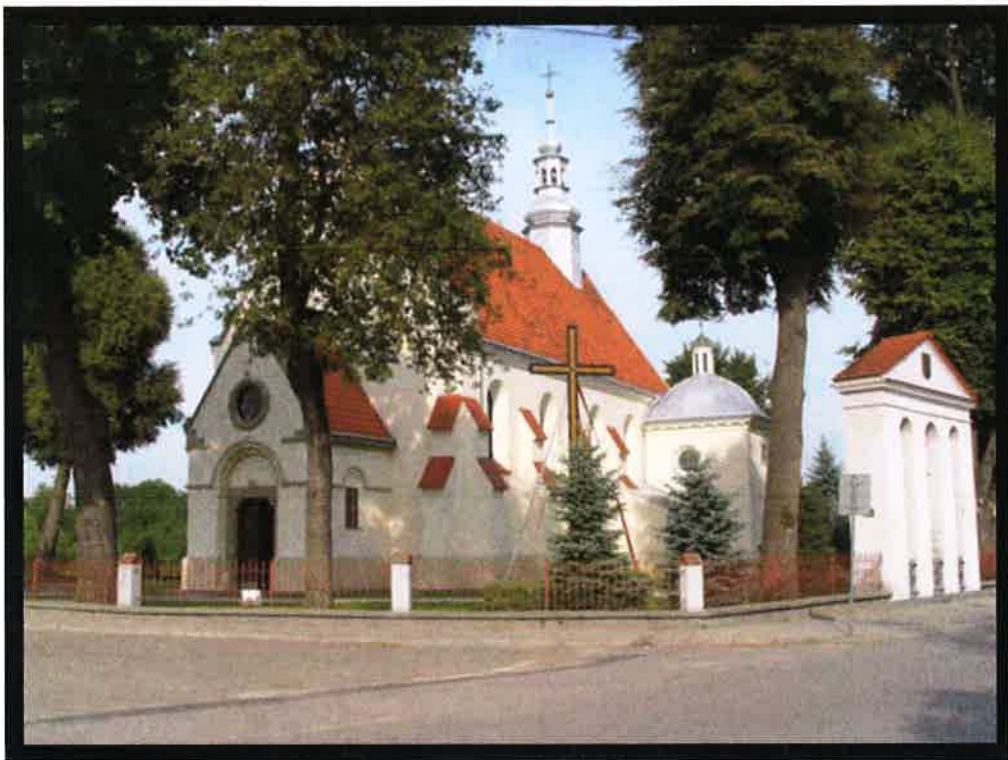
Widok kościoła od strony zachodniej - główne wejście i brama Nr 1;
